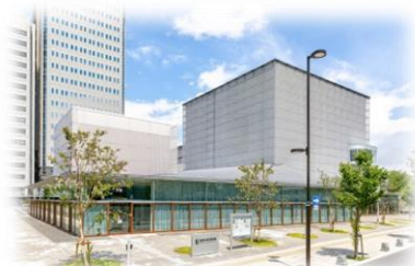
施工実績：静岡市歴史博物館
